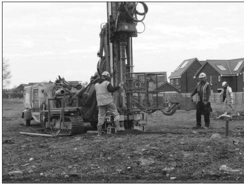
Apertura maniglia della gabbia di protezione - Movimentazione per apertura della porzione di gabbia
