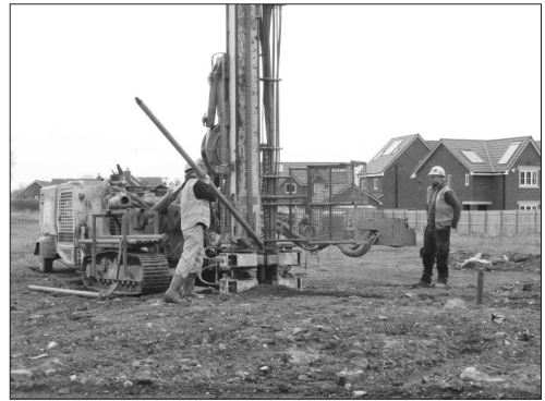
Inserimento e montaggio asta di perforazione
